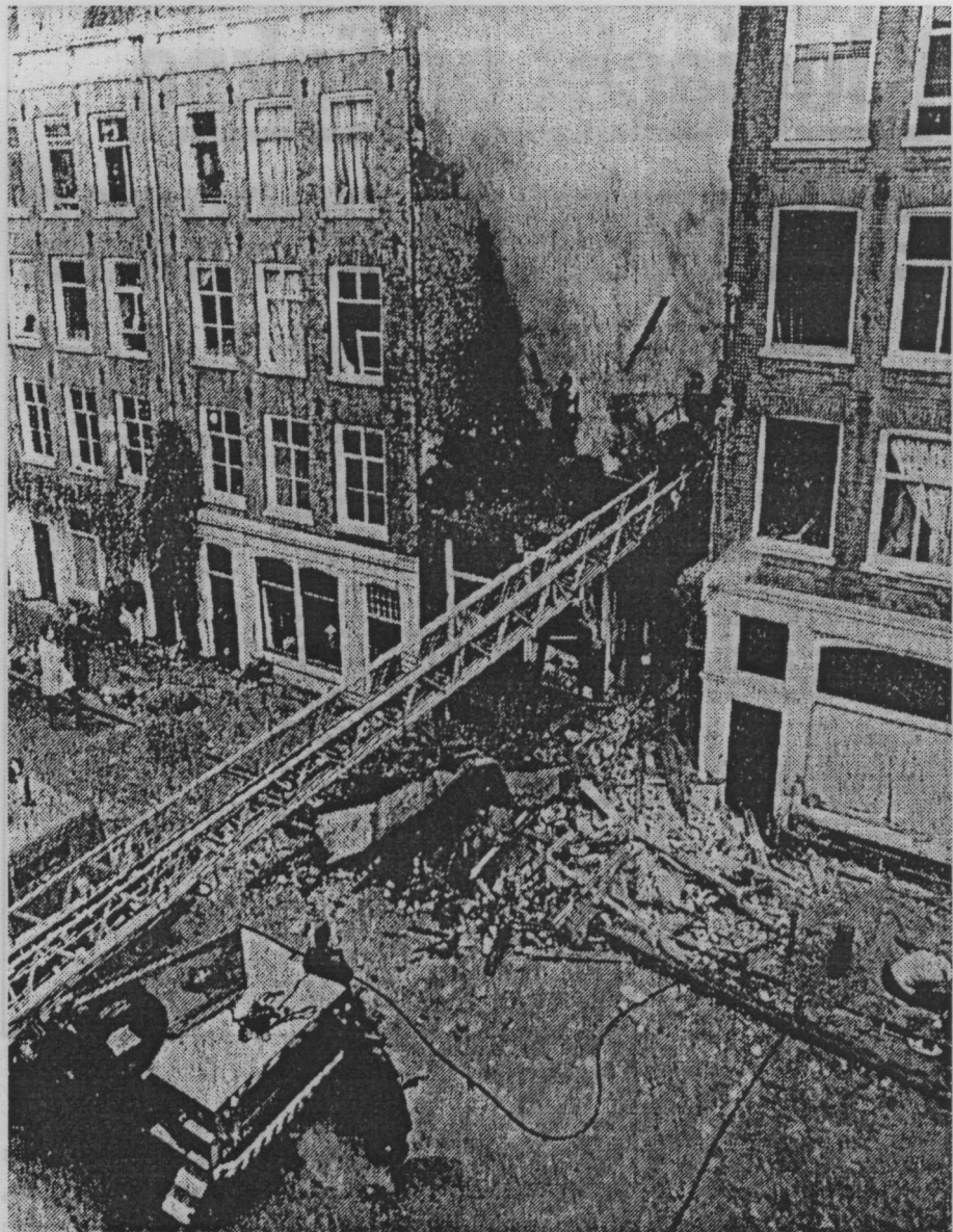
De Telegraaf 17-06-1980: Het pand aan de Quellijnstraat na de ontploffing.
